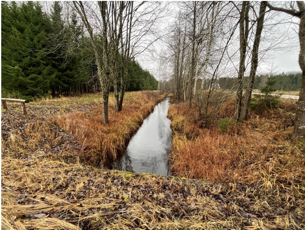
Joonis 2. Aavoja lõik 1 on sirge, järskude nõlvadega ühtlase põhja- ja kaldaprofiiliga.
